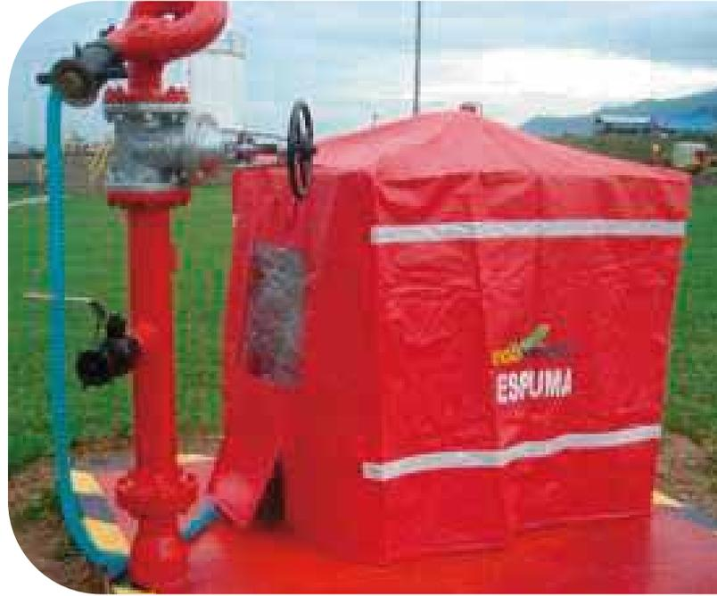
Cubierta protectora para contenedor de espuma (Bulk drum – tote), fabricada en lona Verano - Caribe 100% impermeable y base en
